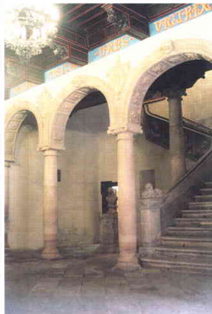
Vestíbulo y escalera principal del Ayuntamiento de Huesca
